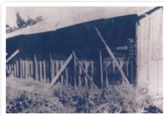
臨時校舎(板橋-下頭橋)
