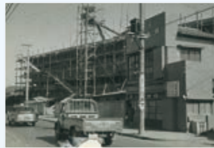
1961~1962年 前校舎建設中
